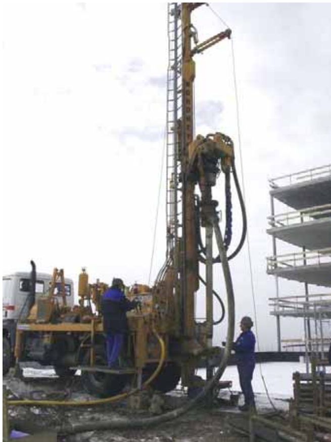
Abb. 33 Bohrung für eine Erdsonde (Bild ebök).
